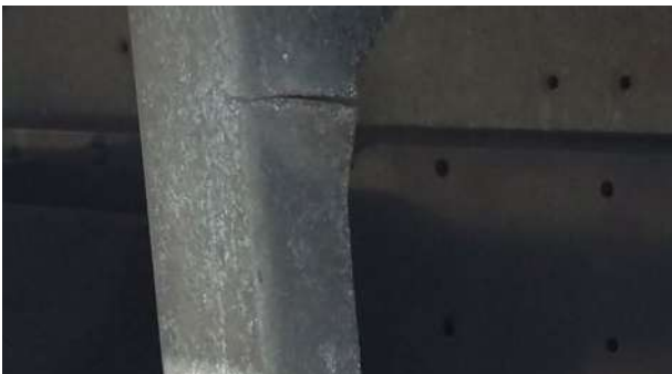
↻ Suportes inferiores: deformação que excedem a reparação económica
