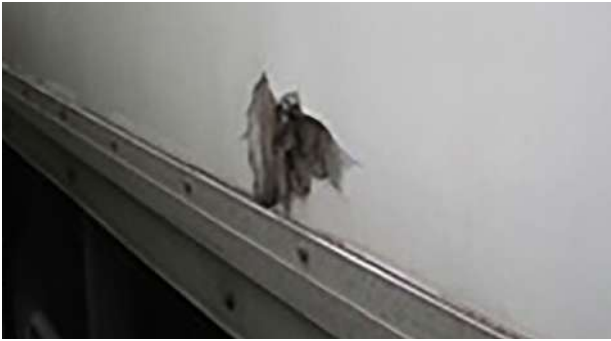
Painéis laterais de madeira: suporte de madeira danificado ≥ 20 cm
