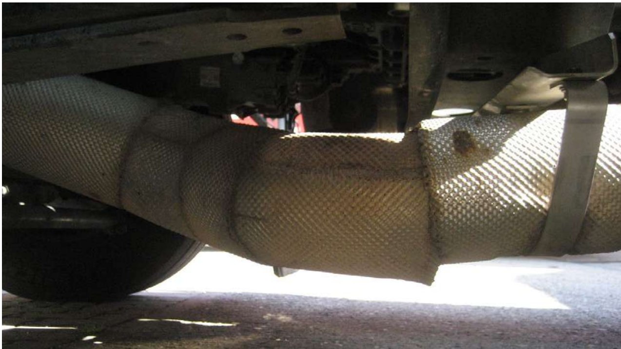
Não são aceites: tubos partidos, isolamento térmico rasgado, riscos profundos no material, mossas que reduzem o diâmetro do tubo.
